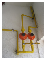
Válvulas de 2º estágio das prumadas de abastecimento de gás
