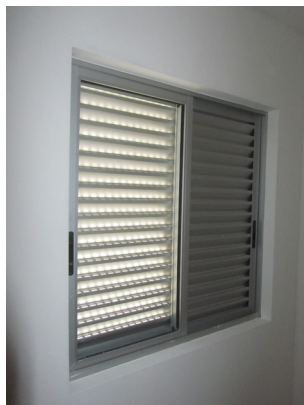
Vista interna da esquadria no quarto de um dos apartamentos
