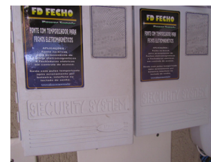
Dispositivos tipo "nobreak" das portas de pedestres
