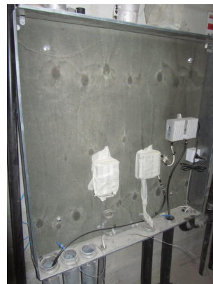
DG de Telecomunicações na garagem 1º pavimento
