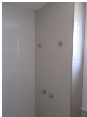
Infraestrutura para chuveiro
