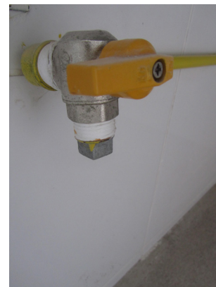
Ponto de gás nos apartamentos
