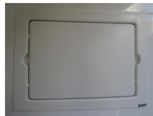
Registro de gaveta - área de serviço - "shaft fechado"
