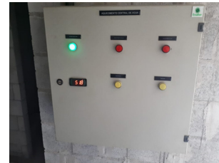
Quadro elétrico de comando
