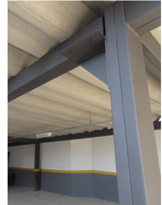
Cobertura das vagas de garagem no 2º pavimento
