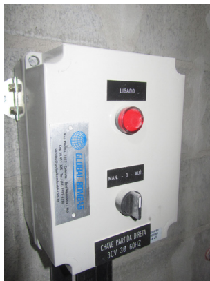
Quadro elétrico de comando da bomba de incêndio
