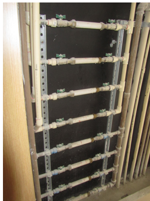
Previsão para hidrômetros individuais
