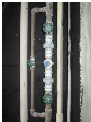
Estação redutora de pressão no 2º pavimento (área comum)
