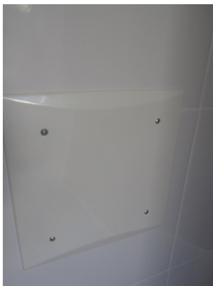
Caixa de telecomunicações na área de serviço do apartamento
