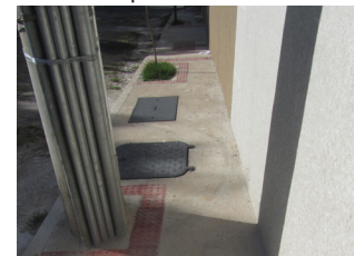
Caixa ZC de entrada de energia
