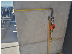
Válvula de 2º estágio do gás (prumada de aquecimento)
