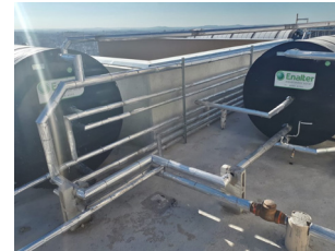
Reservatório térmico solar (boiler)
