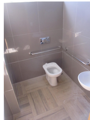
Instalação sanitária adaptada a PNE
