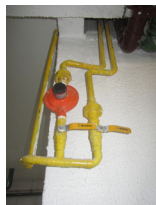
Válvulas de 2º estágio das prumadas de abastecimento de gás
