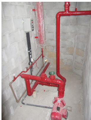
Bomba de incêndio e equipamentos de pressurização
