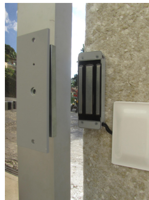
Fechadura elétrica no acesso principal de pedestres
