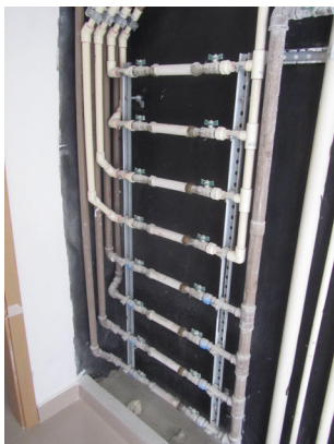
Previsão para hidrômetros de água fria e de água quente
