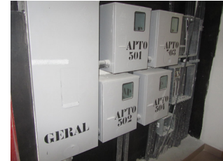
Grupo medidor dos apartamentos no hall do pavimento correspondente
