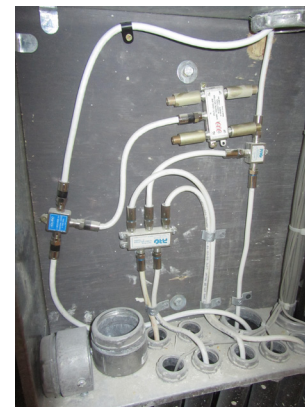
Caixa de passagem no hall do pavimento
