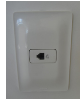
Tomada de telefone padrão RJ-11
