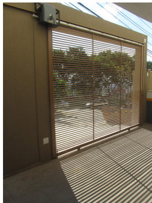
Portão de veículos
