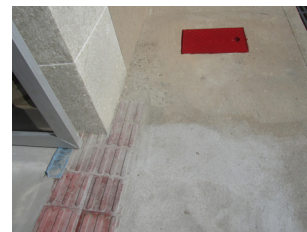
Hidrante de recalque na calçada
