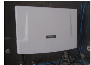
Central de interfonia
