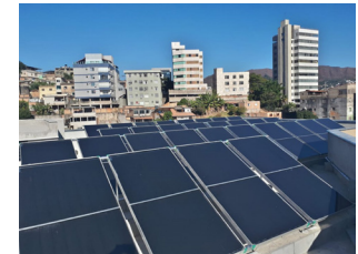
Coletores solares
