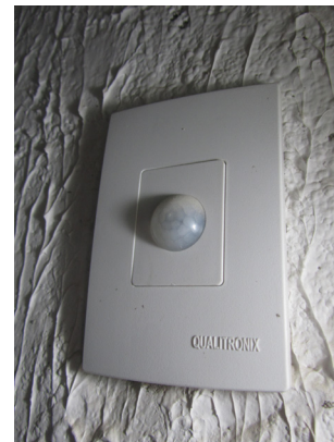
Sensor de presença utilizado no empreendimento
