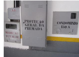
QGBT e Medidor do condomínio na garagem do 1º pavimento
