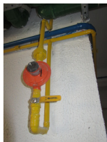
Válvulas de 2º estágio das prumadas de abastecimento de gás
