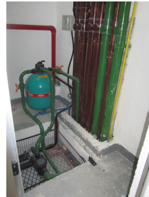
Casa de máquinas da piscina
