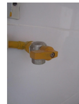
Ponto de gás nos apartamentos
