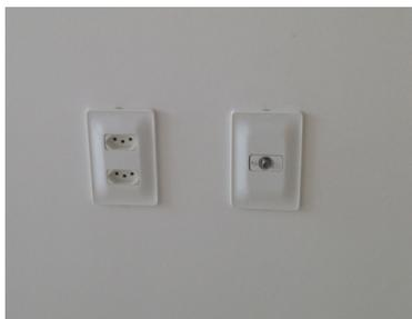
Imagem: Pontos para instalação do sistema de antena coletiva e TV a Cabo
