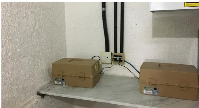
Imagem: Central de baterias, instalada no cômodo da Cemig, 2º pavimento
