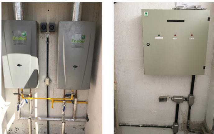
Imagem: Queimadores e quadro de comando e controle, instalados na cobertura do edifício
