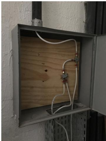
Imagem: Caixa de distribuição de antena e telefonia localizada no cômodo técnico de cada pavimento
