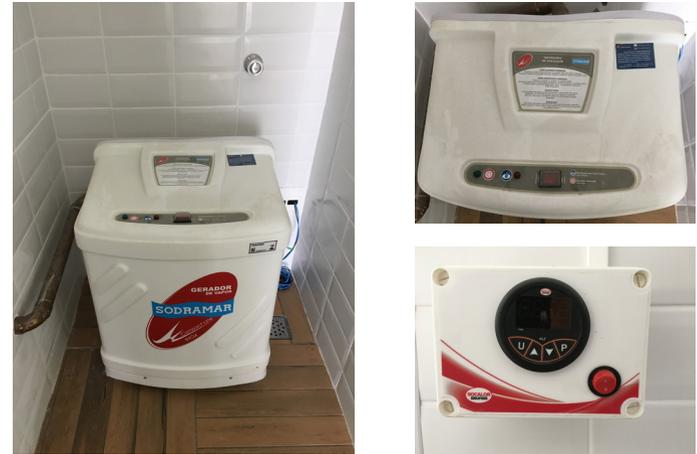
Imagem: Máquina da sauna e o controlador de temperatura
