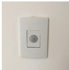
Imagem: Sensor de presença para acionamento da iluminação dos halls e garagens
