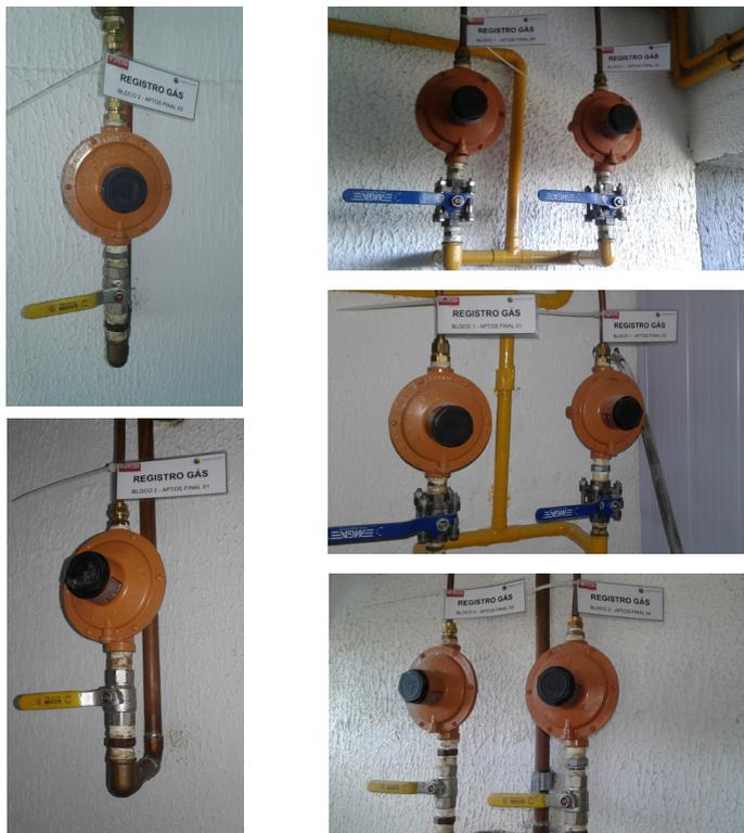
Imagem: Válvulas de corte de gás localizadas na garagem - 2º pavimento
