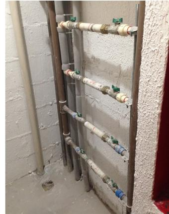
Imagem: Caveleto para instalação de hidrômetros individuais, localizado no cômodo técnico do respectivo pavimento
