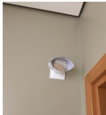
Imagem: Luminárias de emergência, instaladas conforme projeto de incêndio
