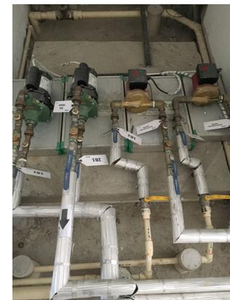
Imagem: Reservatórios de água quente e bombas de recirculação do sistema, instalados na cobertura do edifício
