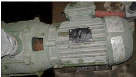
Imagem: Bombas de recalque, instaladas junto aos reservatórios inferiores
